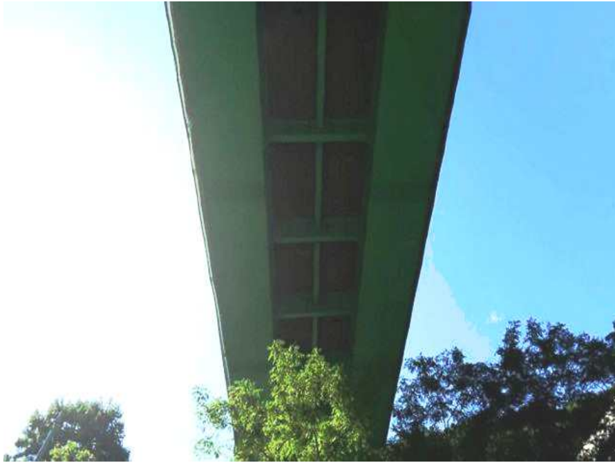
바닥판하면 및 강박스 외부전경
